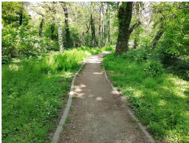
Уређена стаза са бетонским ивичњацима и ризлом
